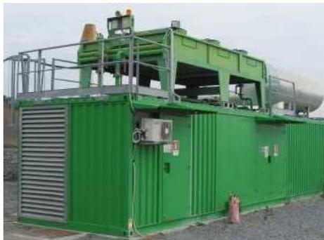
Figura 10 – Impianto biogas discarica
