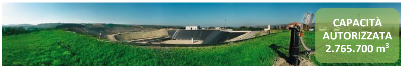
Figura 4 – Vista della discarica di Cerratina
